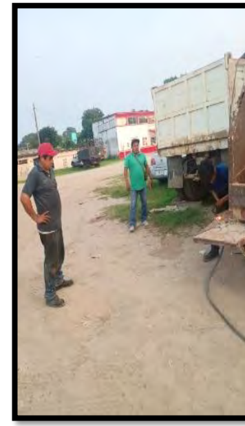
❖ Reparación de estribos
